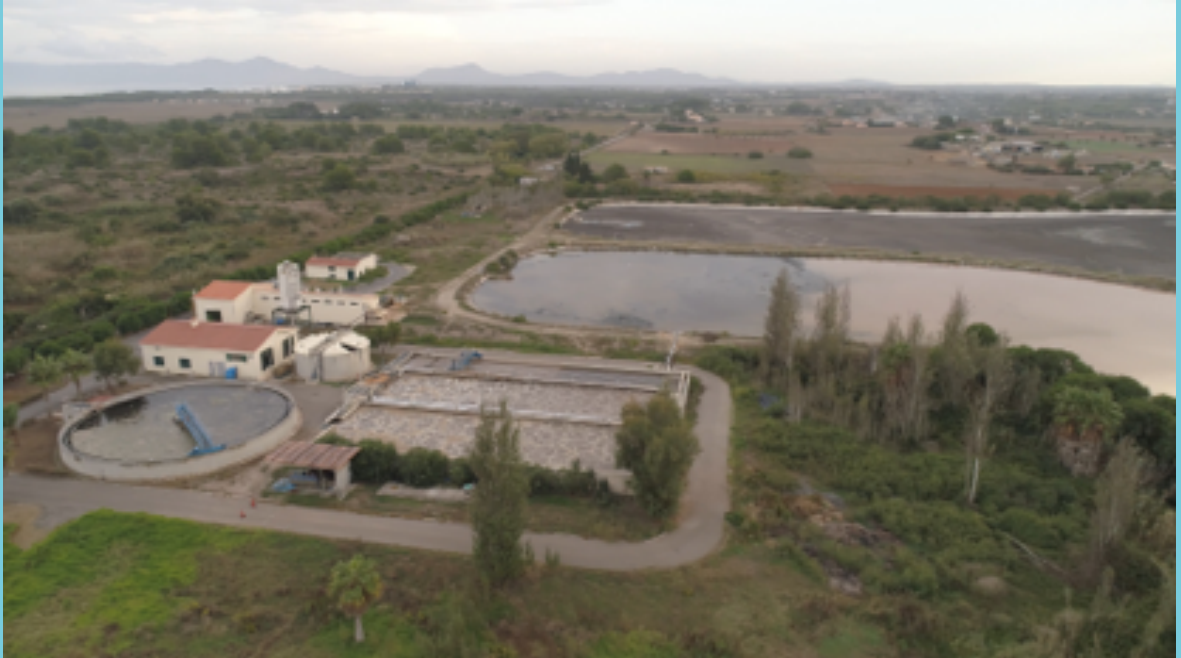
Fotografía aérea de la estación depuradora de aguas residuales de Can Picafort (Son Bosc).
